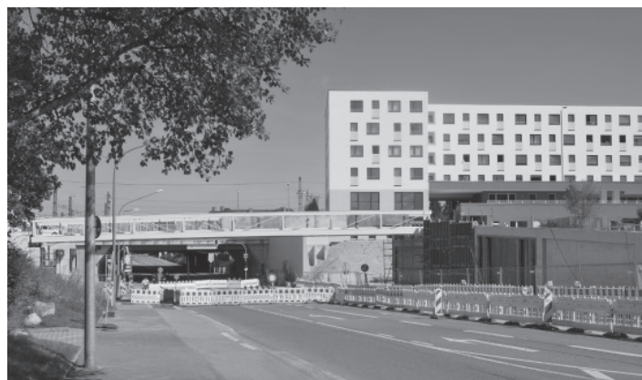
Am 14. September wurde die neue Brücke in Verlängerung des „Paseo“ von den Pasing Arcaden zum Neubaugebiet auf dem vormaligen Stückgutgelände eingehoben. Hier entsteht ein neues Kulturzentrum. Foto: Frieder Vogelsgesang
