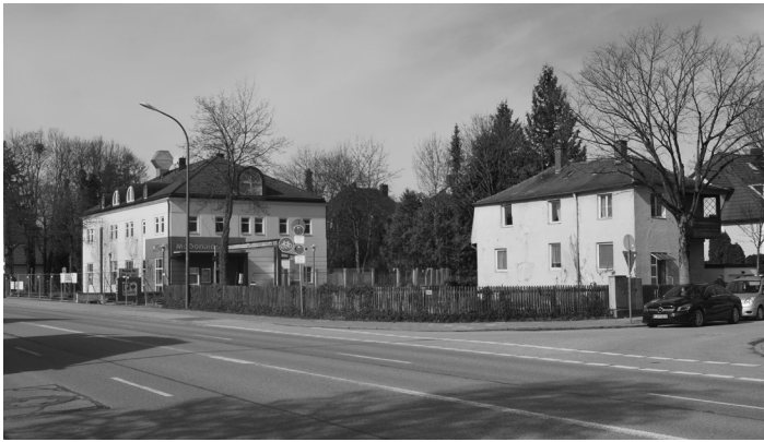
Der McDonalds an der Verdistrasse wird abgerissen. Foto: fv
