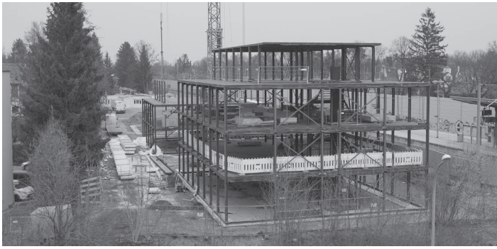
Baubeginn für das Sozialprojekt am Bahnhof Obermenzing.
