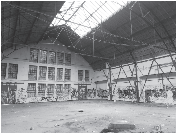
Innenansicht der unter Denkmalschutz stehenden Industriehalle der ehemaligen Pasinger Eggenfabrik. Foto: Frieder Vogelsgesang
